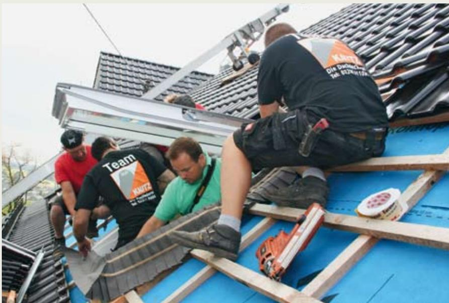
5 Mann, ein Fenster – da jeder etwas sehen und lernen wollte, drängte man sich dicht um das „Referenzobjekt“ – hier bei der Montage der BDX-Schürze (Schottenrock), welche bei den neuen Modellen seitlich geklebt wird.
